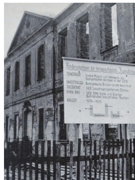
Das sogenannte Herrschaftshaus, die größte der noch ausbaufähigen Kriegsrüinen Herrnhuts
