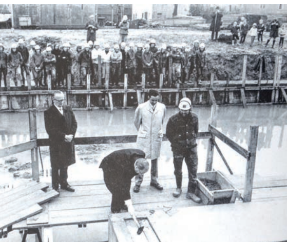
Baugrube zur Grundsteinlegung des Förderungszentrums am 18. Oktober 1974
